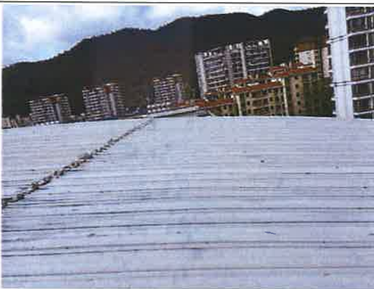
建筑现状完好
