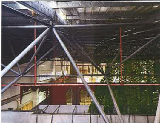
建筑现状完好
