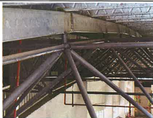
建筑现状完好
