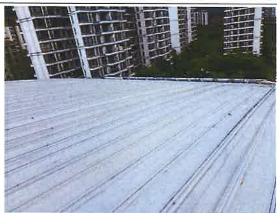
建筑现状完好
