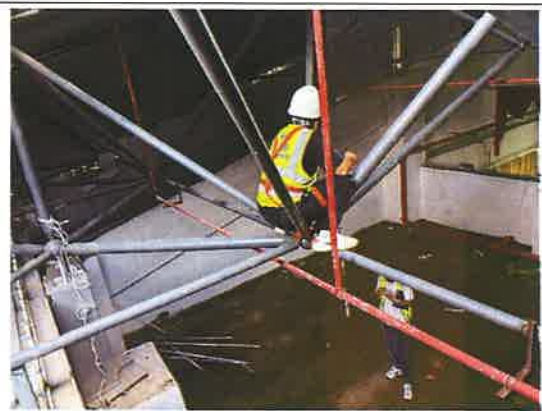
建筑现状完好、构件强度检测
