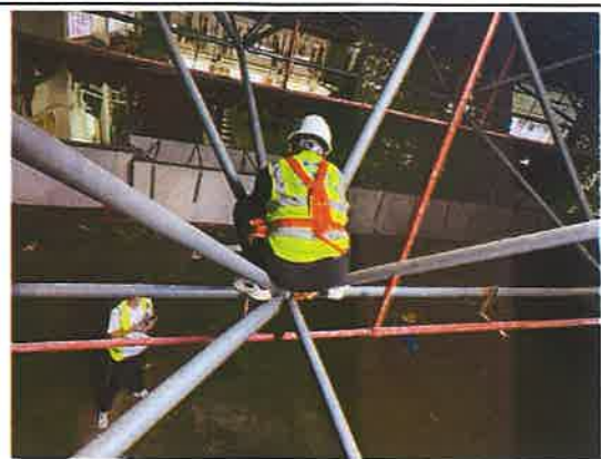
建筑现状完好、构件强度检测
