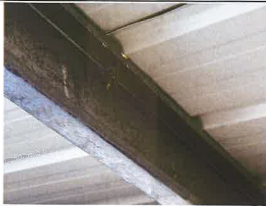
建筑现状完好
