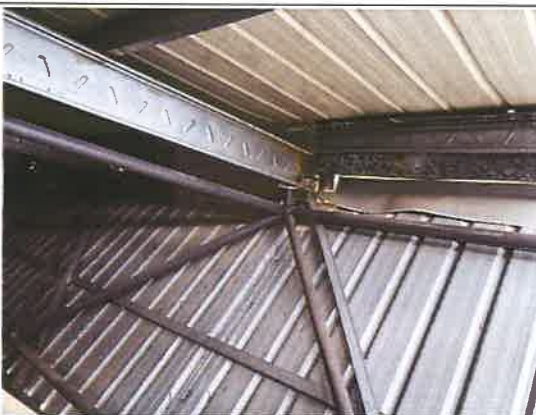
建筑现状完好
