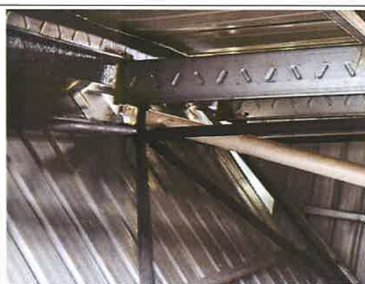
建筑现状完好
