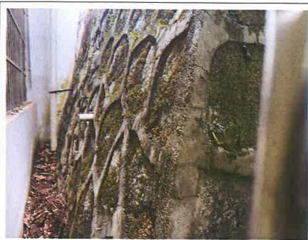
摩托车实训室挡土墙
