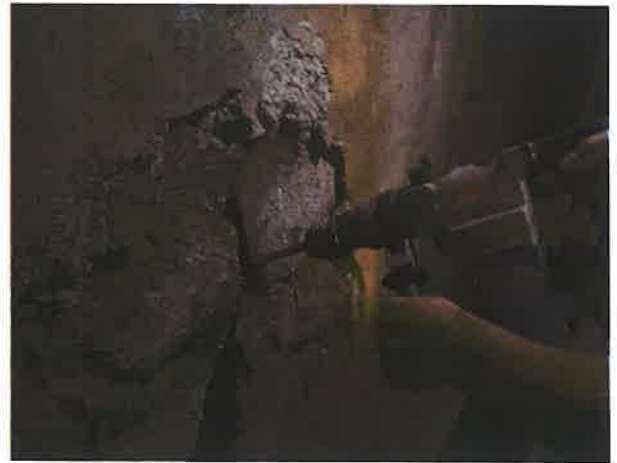
现场检测照片
