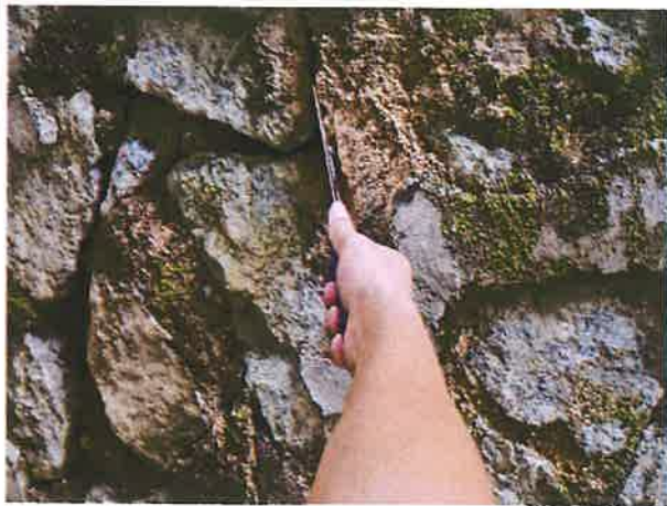
现场检测照片
